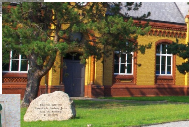
die Agricola-Turnhalle in der Steintorstraße, Schulsportstätte und „Heimstatt“ des Turnvereins TV Jahn e.V.
